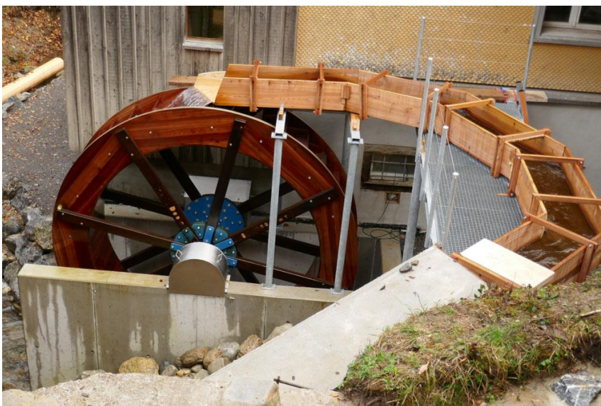
Gesamtansicht Wasserrad und Oberwasserkanal aus Lärchenholz
