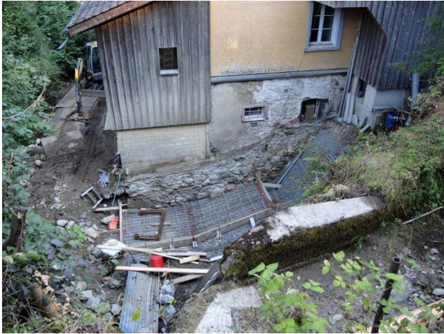
Vorbereitung Bodenplatte
