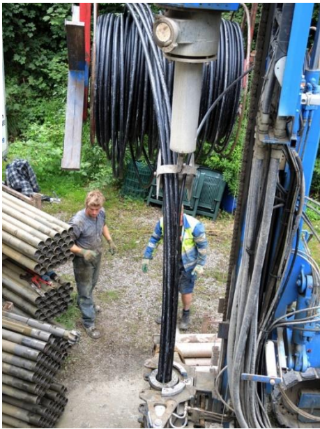
Einziehen der Sonde
