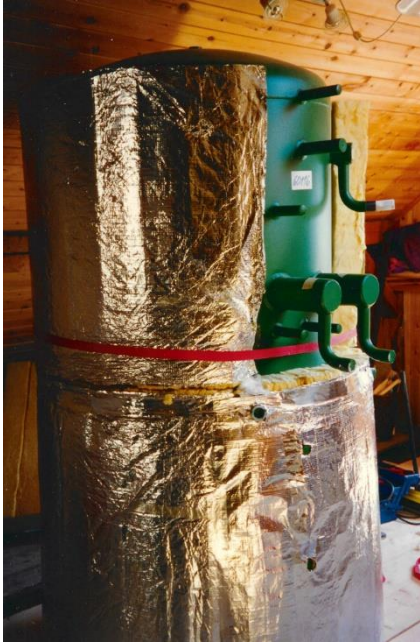
Kleiner Speicher 850 Liter mit Spira-Integralboiler
