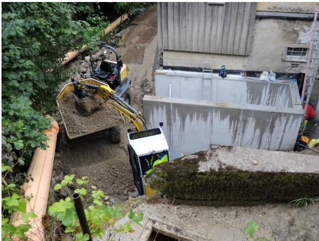
beim Hinterfüllen
