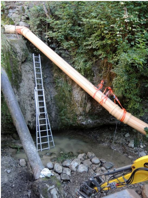
Der Bach wird trockengelegt
