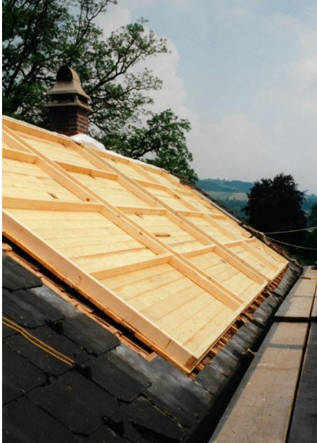
. Unterkonstruktion aus Holz
