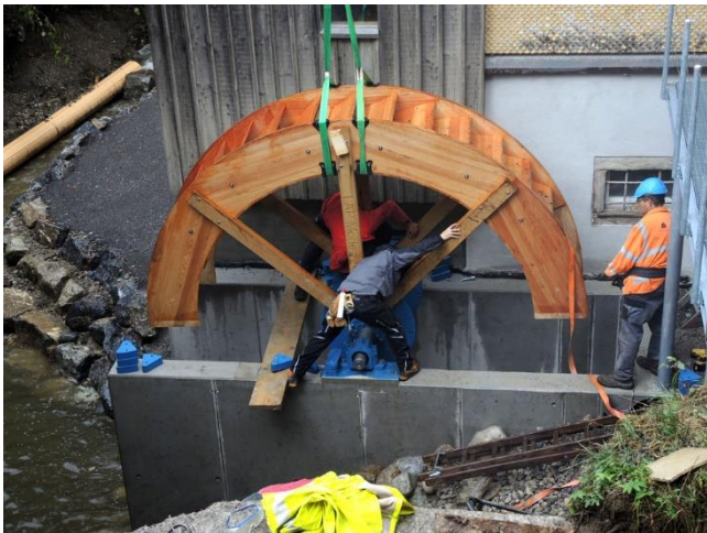
Befestigung der Speichen an den Rosetten
