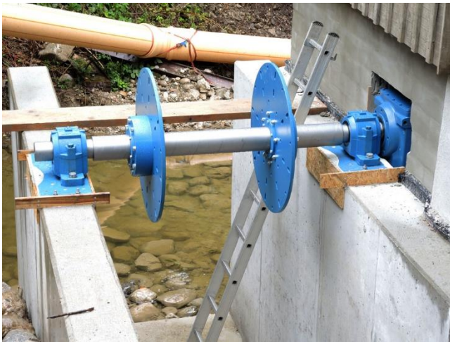
Wellenlager justieren und einbetonieren
