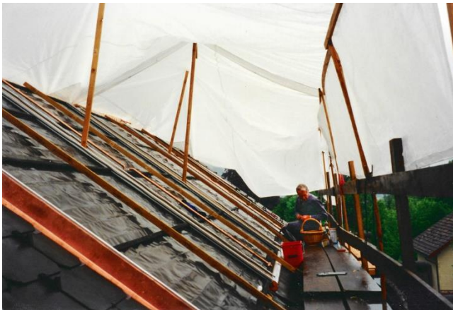
. Absorber sind eingelegt und werden gelötet
