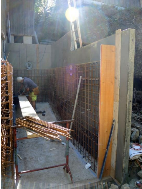
Einbringen der Armierung
